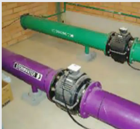
شکل ۴) تفکیک رنگ لوله‌های آب شرب از آب غیرشرب بهداشتی خانگی در شبکه دوگانه
